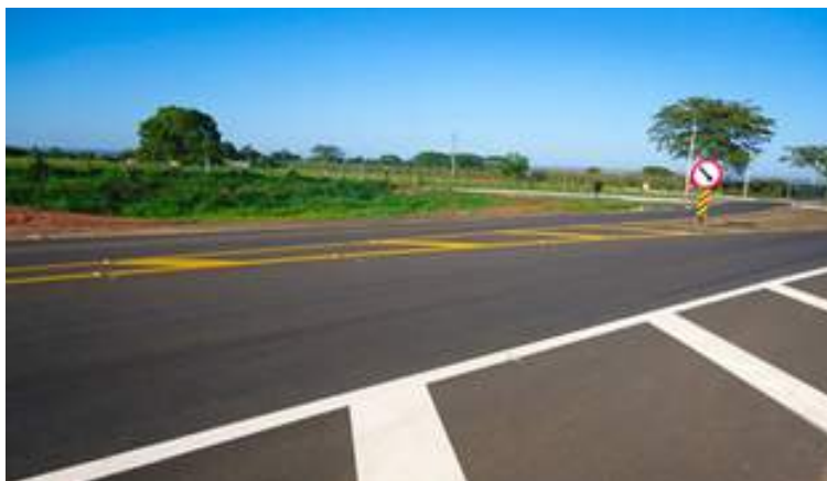
Figura 5.22 – Sinalização horizontal, termoplástico extrudado. Disponível em: < http://www.vinepaineis.com.br/sinalizacaohorizontal.html >. Acesso em: 12 dez. 2017.
