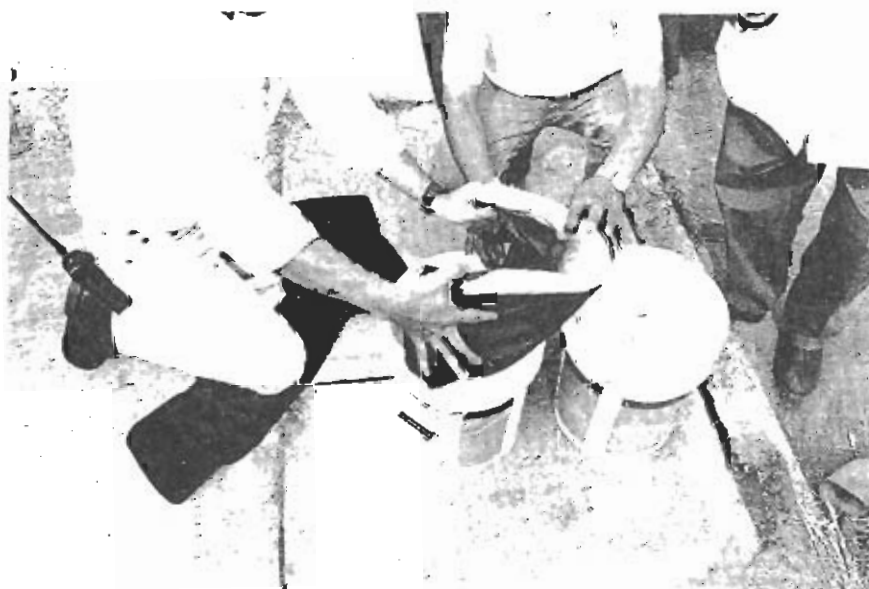
Inmersión de los paneles balísticos en agua
